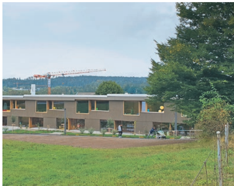
Vor drei Monaten wurde das neue Schulgebäude feierlich eingeweiht. (Bild: Archiv)
